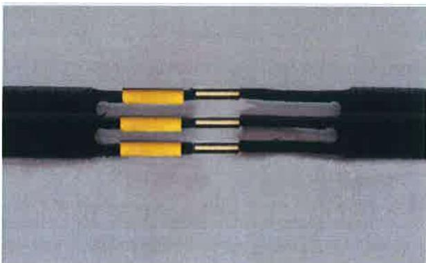
Произвести соединение кабельных жил с помощью обжимных втулок и опрессовать втулки обжимными клещами. Каждую обжатую втулку необходимо пропаять с использованием неактивного флюса и газового паяльника.
