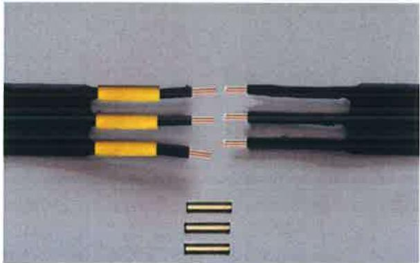
Снять изоляцию каждой соединяемой жилы на 10-12 мм от ее окончания. Зачистить освобожденные от изоляции жилы кабеля при помощи наждачной бумаги до медного блеска. Надеть на каждую пару соединяемых жил одного цвета термоусаживаемую трубку диаметром 4 мм и длиной 45 мм (рис. 3).
