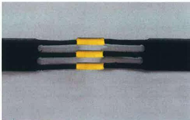
Усадка предварительно надетой термоусаживаемой трубки на соединенной кабельной жиле производится таким образом, чтобы нахлест трубы на изоляцию соединенной жилы был равномерным и составлял около 10 мм с каждой стороны соединительной втулки. Усадку производить газовым паяльником. При усадке пламя горелки необходимо удерживать на расстоянии не ближе 5-7 мм от трубы. Соединение жил кабеля производить последовательно.
